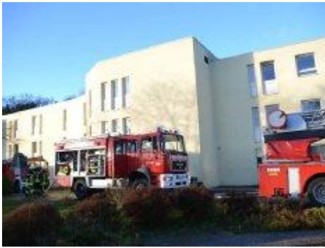
Nicht mehr bewohnbar ist nach einem Brand ein Gebäudekomplex des Bad Münstereifeler Seniorenzentrums „Otterbach“. (Foto: Arndt)
